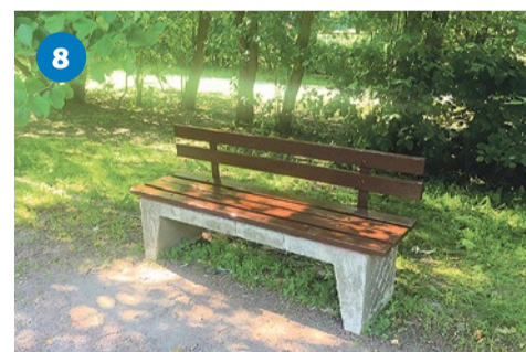
Скамейка после ремонта
