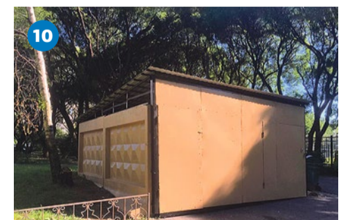
Контейнерная площадка после ремонта
