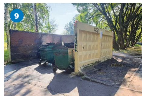
Контейнерная площадка до ремонта
